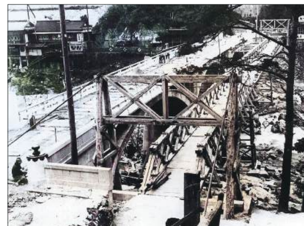
左側、現在の三連アーチ橋工事中、右側二代目の吊り橋の城嶺橋(定光寺町)
