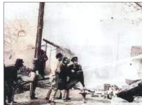
大火災の消火にあたる消防団 昭和28年4月28日、上品野の民家から 出火した火災は、13戸を全焼、4戸を半焼 する大火となりました
