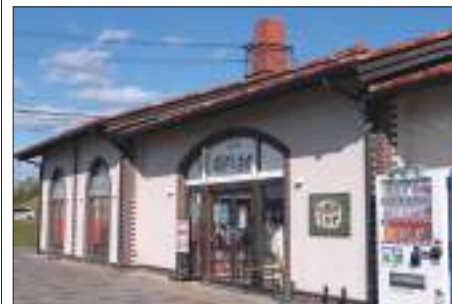
道の駅「瀬戸しなの」(品野町1丁目)
