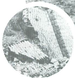
▲ 運動場北側擁壁崩壊
