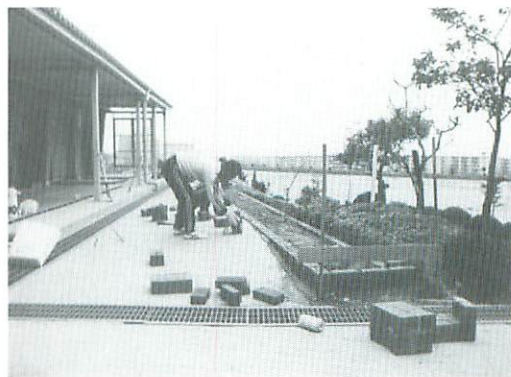
▲ P T A 作業により花だん完成 (54年度)
