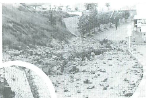
▲ 運動場北側擁壁崩壊
