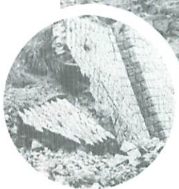
▲ 運動場北側擁壁崩壊
