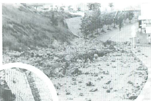
▲ 運動場北側擁壁崩壊
