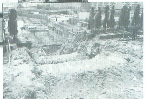
▲ プール建設工事
