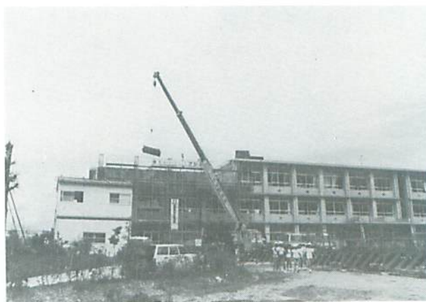
▲ 8月13日より 校舎増築工事開始
