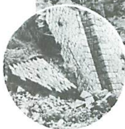
▲ 運動場北側擁壁崩壊
