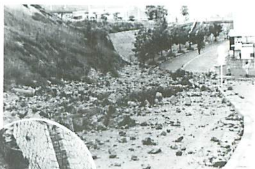
▲ 運動場北側擁壁崩壊
