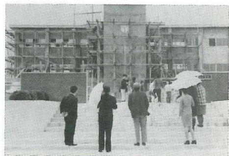
▲完成間近の第2期校舎増築部分
