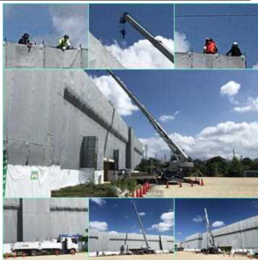
大規模改修（雨漏り修理）の様子
